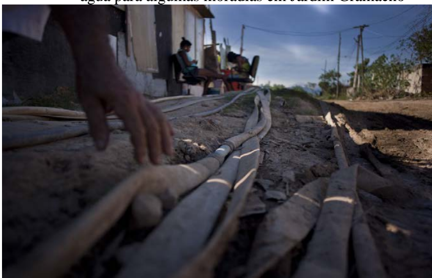
Figura 19 - Bombas de água improvisadas pelos moradores que levam água para algumas moradias em Jardim Gramacho
